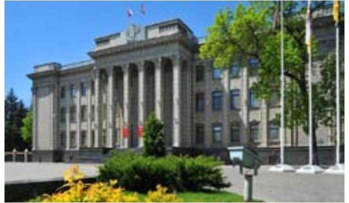
Законодательное собрание Краснодарского края (Здание окружного суда, реконструкция 1949 -1953 г.г., архитектор А.Н. Стемальщук)
